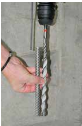
Fig. 5a Régler la profondeur de perçage
