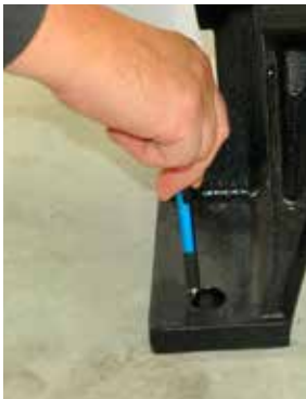
Fig. 8a Marquer les trous de perçage
