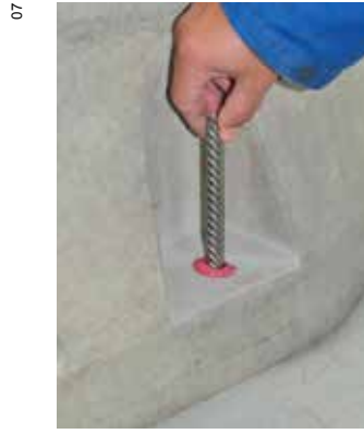
Fig. 6b Mettre l'armature en place
